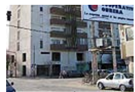
FOTOGALERÍA El abandono domina las torres de Cinco Saltos
